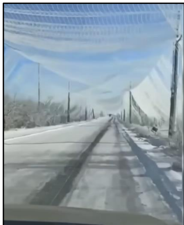
Illustration 4 : Filet anti-UAS déployé sur la BSR 13 reliant Tchassiv Yar et Bakhmout. 14
